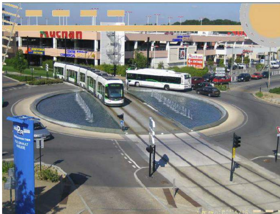
Mynd 13: Dæmi um hvernig léttlest í miðlegu er leidd í gegnum hringtorg (Nantes, Frakkland).
